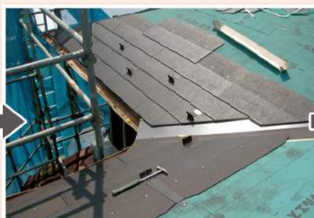
谷になる部分には板金を入れて 屋根材を葺き、雪止めをつけます。
