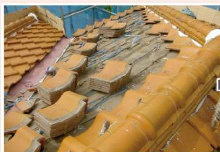
足場を組み、既存の瓦屋根を撤去。 瓦は機械で下まで降ろします。
